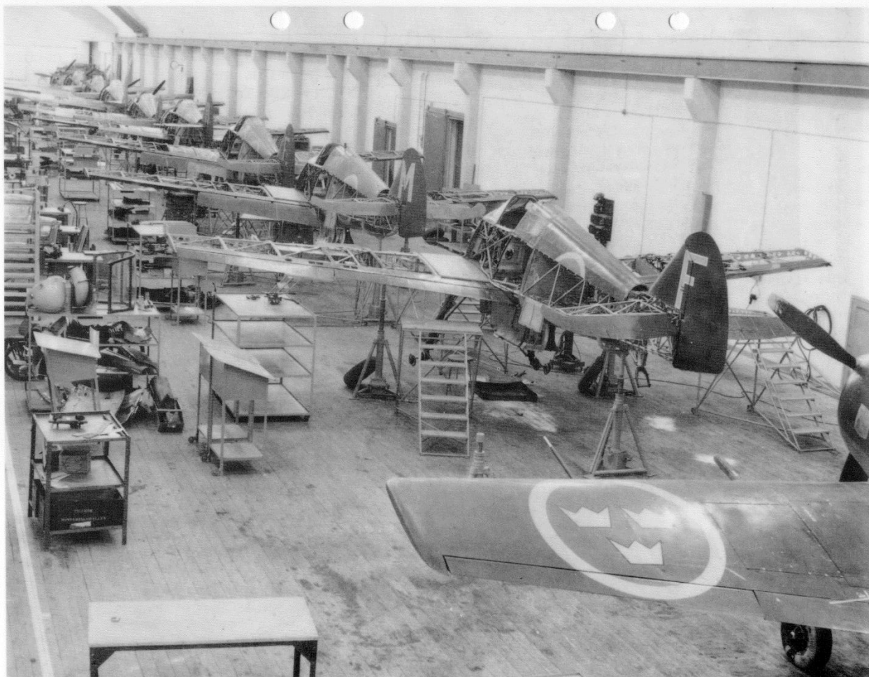
Redan i januari 1945 började CVA (Centrala Flygverkstaden i Arboga) att utföra underhållsarbete på J 22. Bilden visar de bombskyddade lokalerna i berggrummet.
